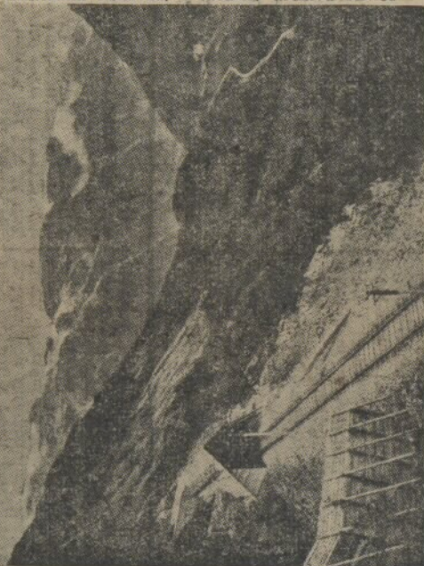
Tunely a paliády na bergenské dráze.
