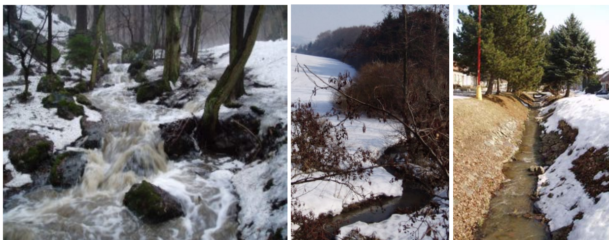
Obr. 6 Proměna charakteru pravostranných přítoků Rakovce (od horské bystřiny přes meandrující tok až po narovnané „kanalizované koryto“) na příkladu Vítovického potoka; leden – březen 2006
