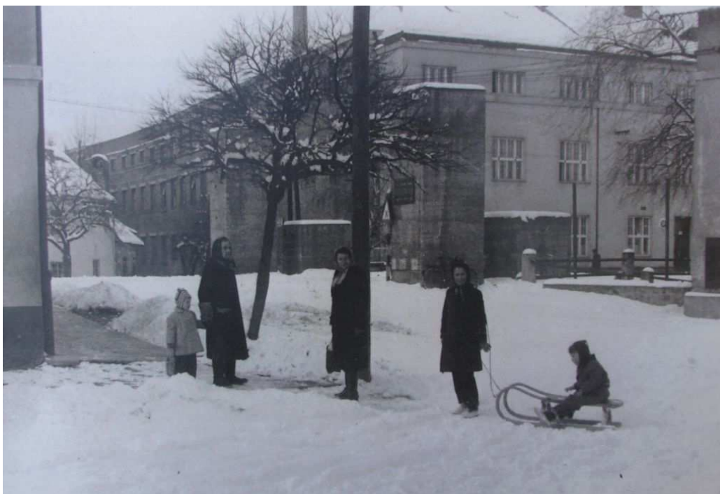
3. Podminované betonové pilíře v Rousínově. (Soukromá sbírka Václava Sedlmajera z Rousínova).
